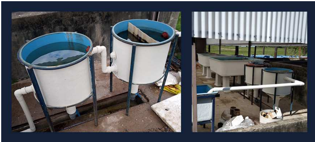
Figura 4: Filtros mecánicos en construcción: sedimentador y separador de sólidos.
